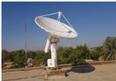
Station RARS installée sur le toit du bâtiment d'AGRHYMET (Niamey- Niger)
